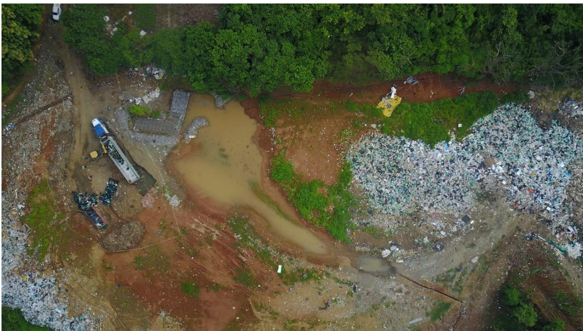
Figura 3. Área de transferencia de residuos en antiguo vertedero municipal en octubre de 2017 Fuente: Fotografía aérea obtenida mediante dron, autor desconocido, 2017
