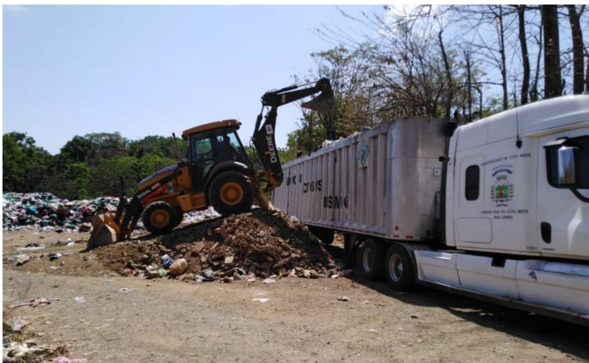
Figura 15. Sistema de transferencia provisional implementado en antiguo botadero municipal Fuente: Elaboración propia, 2019
